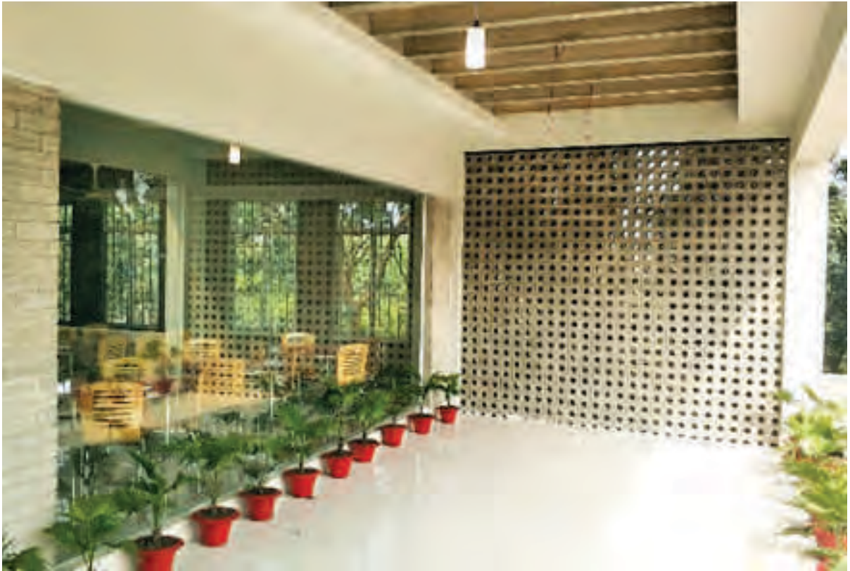
প্রতিষ্ঠানের তৃতীয় তলার সম্প্রসারণকৃত স্থাপনায় নন ফায়ার্ড সলিডিফিকেশন ব্রিকস ব্যবহার করে নির্মিত স্ক্রিন ওয়াল
